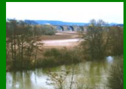
Die Autobahnbrücke bei Maua
