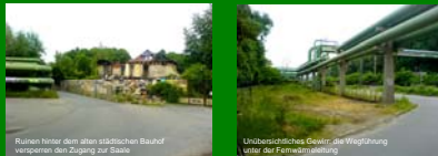
Ruinen hinter dem alten städtischen Bauhof verperren den Zugang zur Saale
